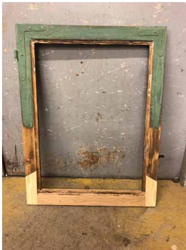
Trälagningar fick göras på en del av fönsterbågarna i Grevagården.
