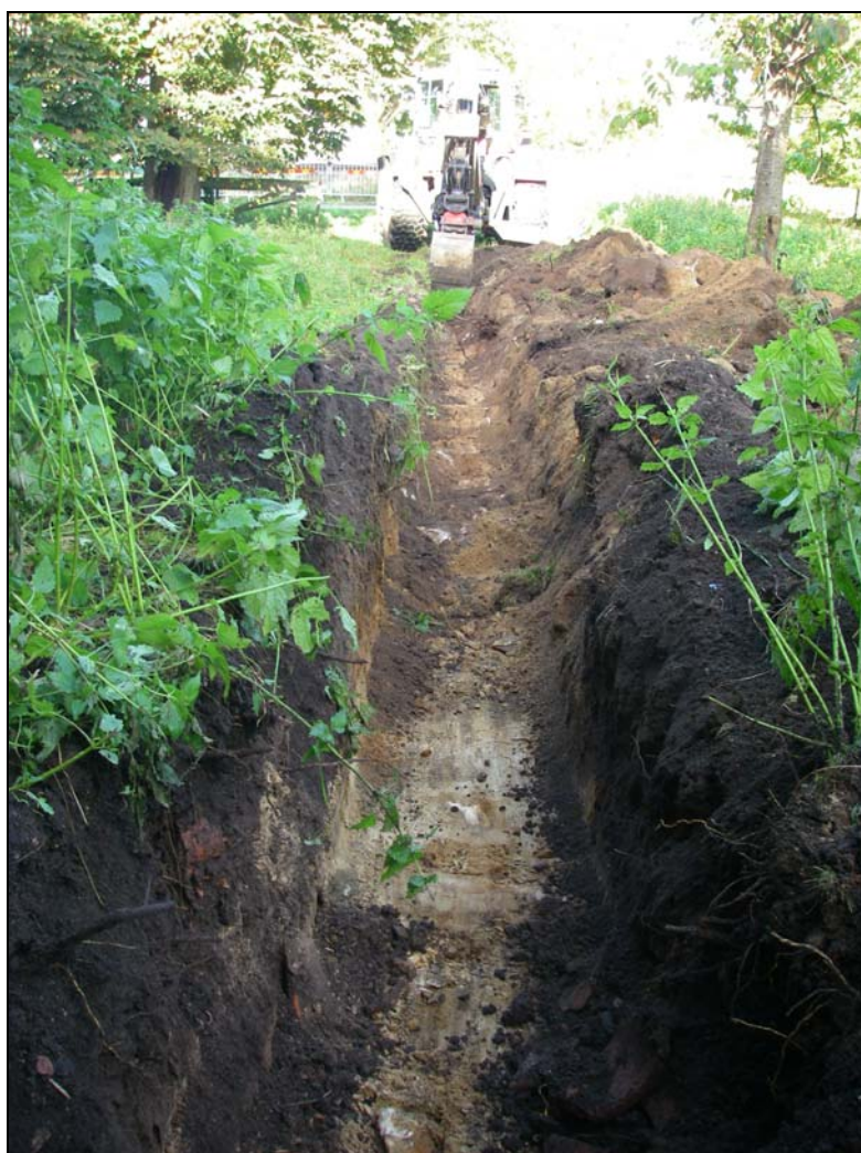
Parti av exploateringsschaktet mot NV
