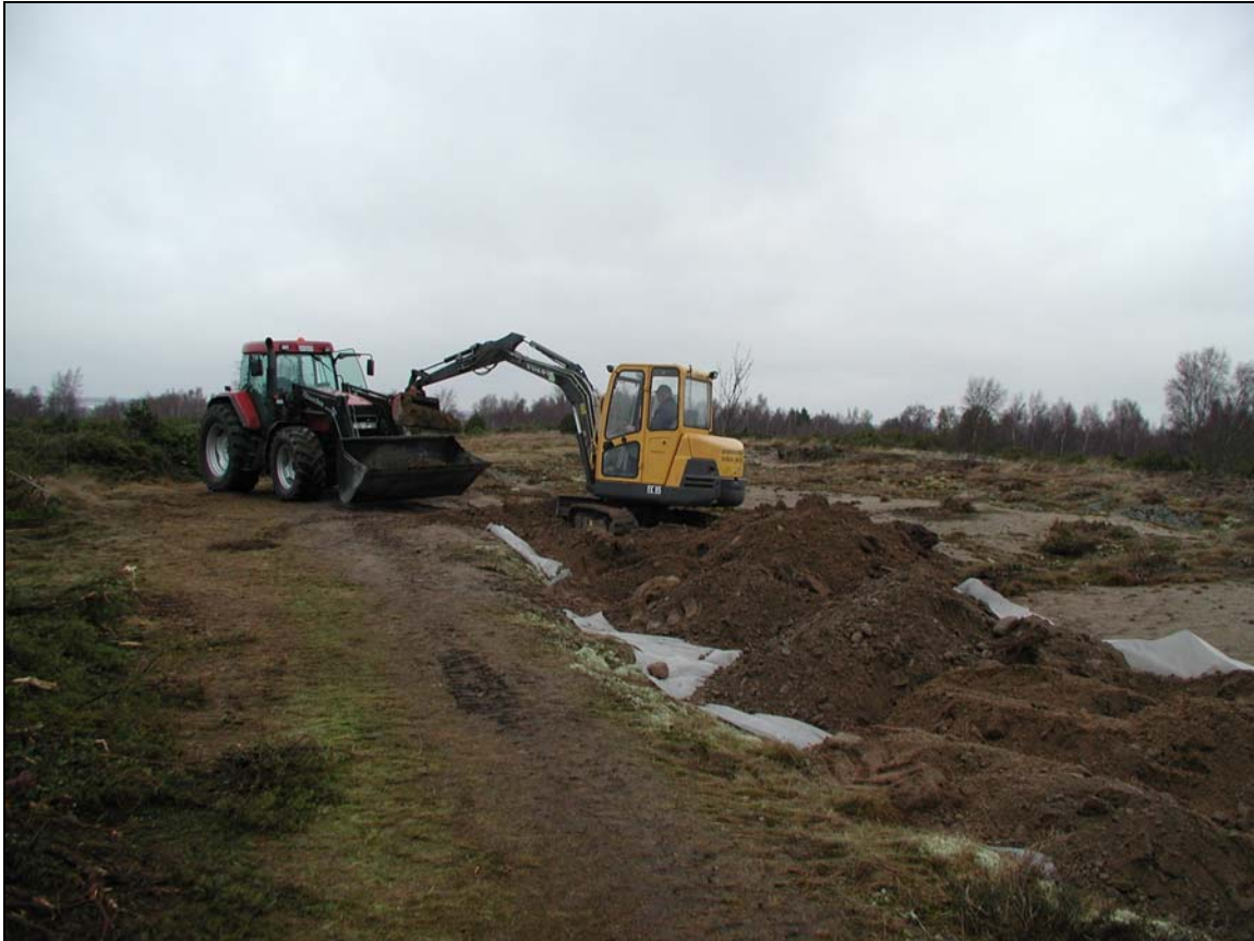
Bilaga 1e – Pågående igenfyllnad av sandtakter.
